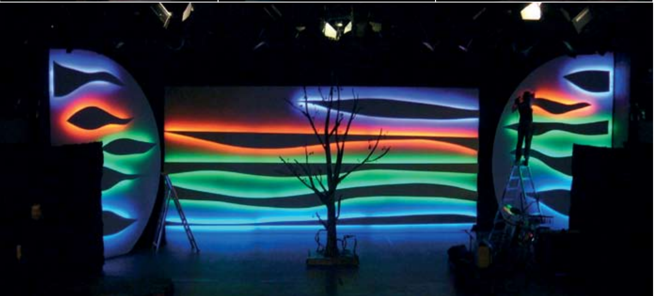
Ljuset från diodmodulerna fungerar som backlights och reflekteras mot den vitmålade fonden. De färgade dioderna ljusregleras individuellt, med hjälp av elektroniska styrdon från OSRAM. Mycket exakta färgregleringar kan programmeras i förväg eller styras manuellt.
