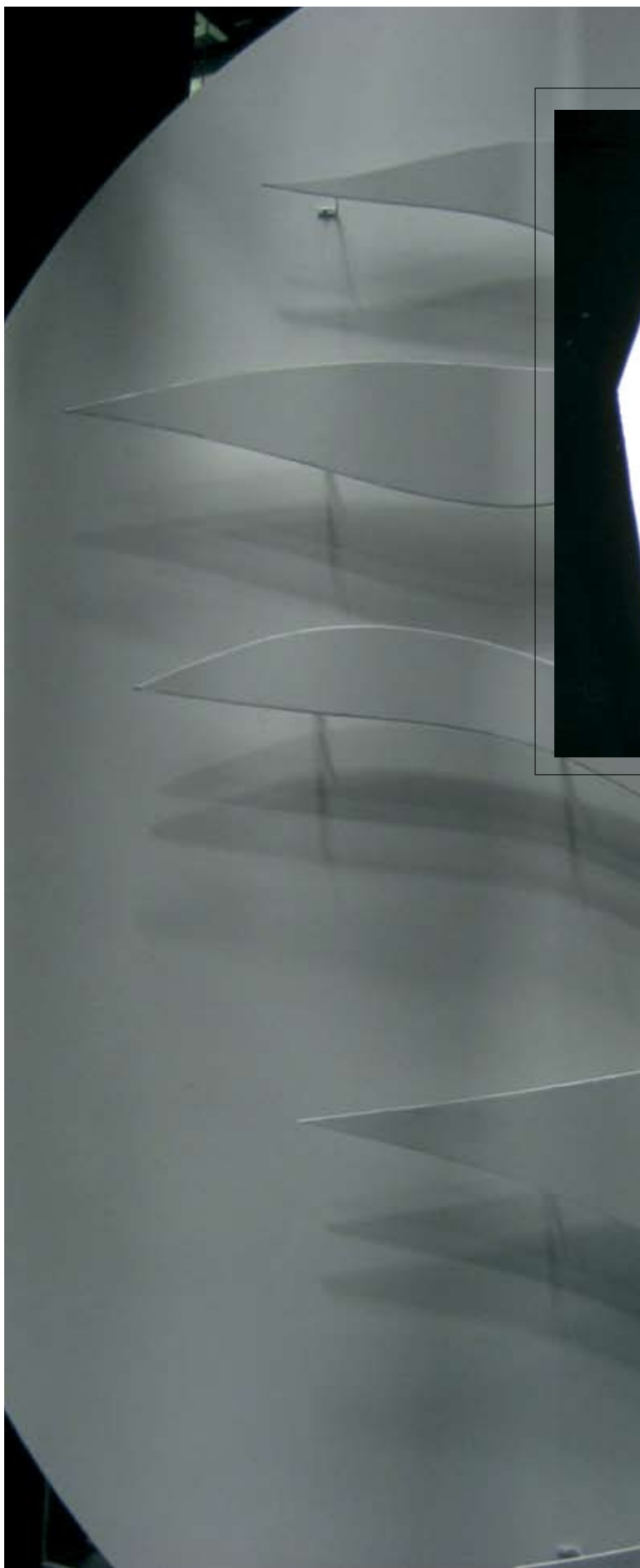
Fonderna har vågformade reliefer. På insidan av varje våg löper en enkel rad med färgväxlande diodtejp av typen LINEARlight Flex.
