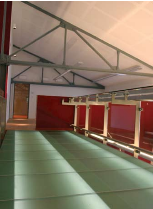
En passage har utformats som en genomlyst glasbro. I aluminiumprofiler monterades vita diodljuskällor av typen LINEARlight® FLEX, en nyhet som erbjöd just den flexibilitet som projektet krävde.
