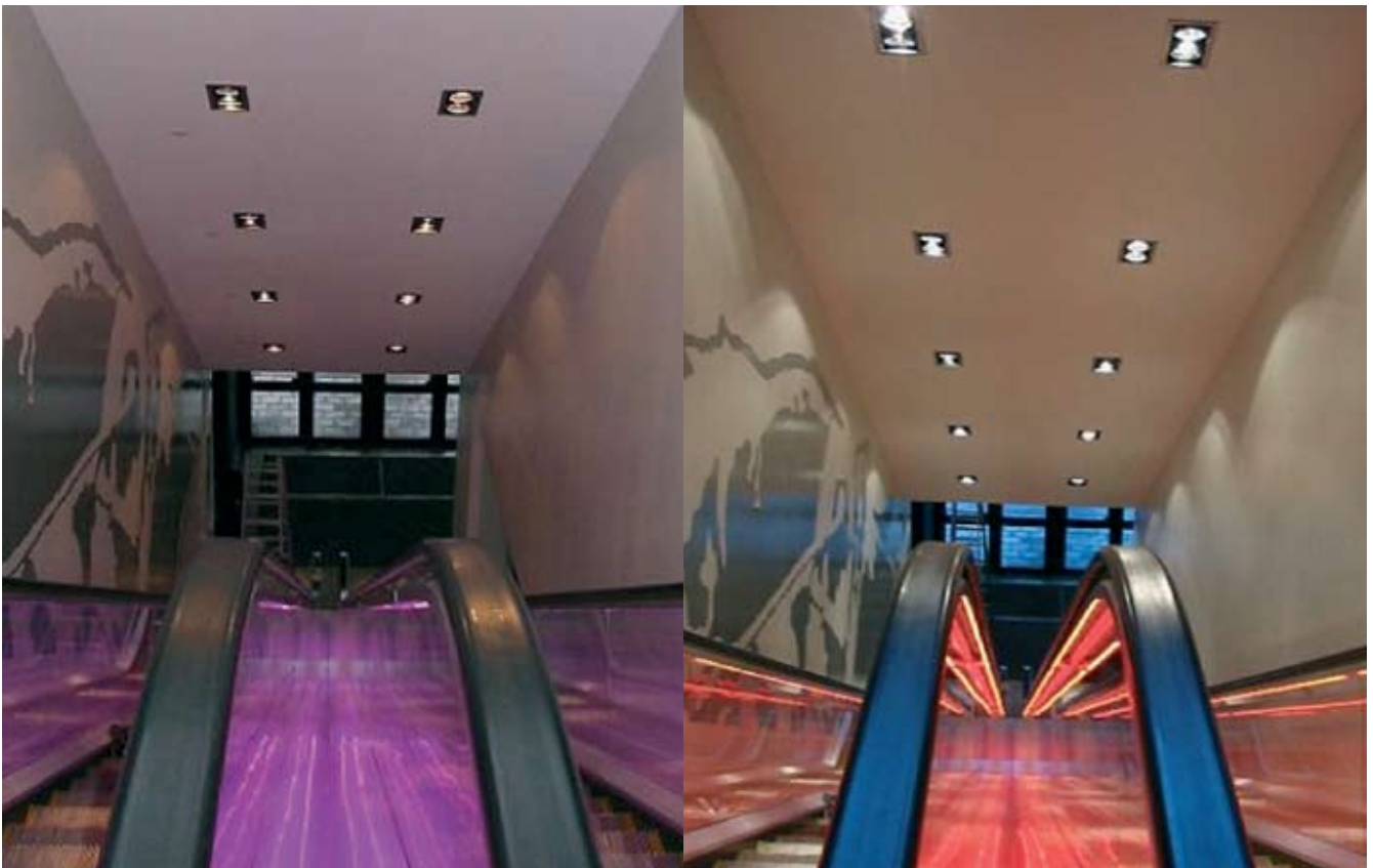
I trapphusets tak har halogenspotlights fällts in. Ljusstarka HALOSPOT från OSRAM ger en modern och exklusiv atmosfär.
